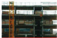
Un edifici en construcció © ACN
