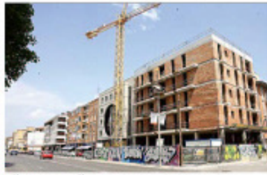
Habitatge en construcció a la ciutat de Girona. API, Girona, 11 de novembre de 2011.
